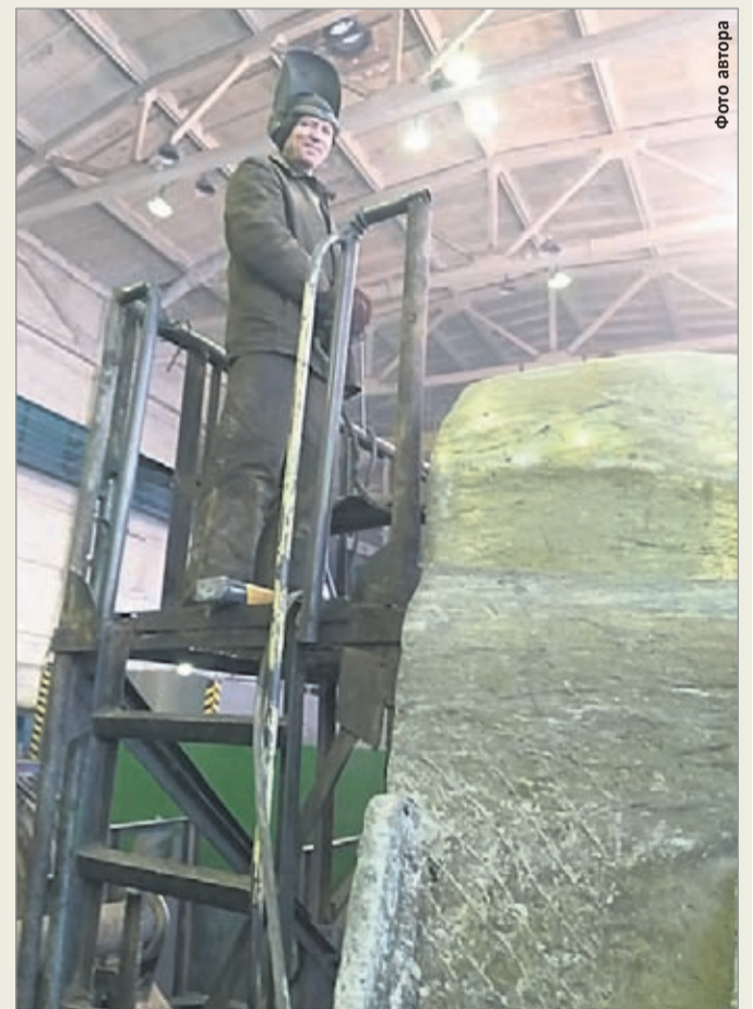
Сварку элементов ковша экскаватора ЭКГ-10И №83 выполняет электрогазосварщик Валентин Слободчиков
